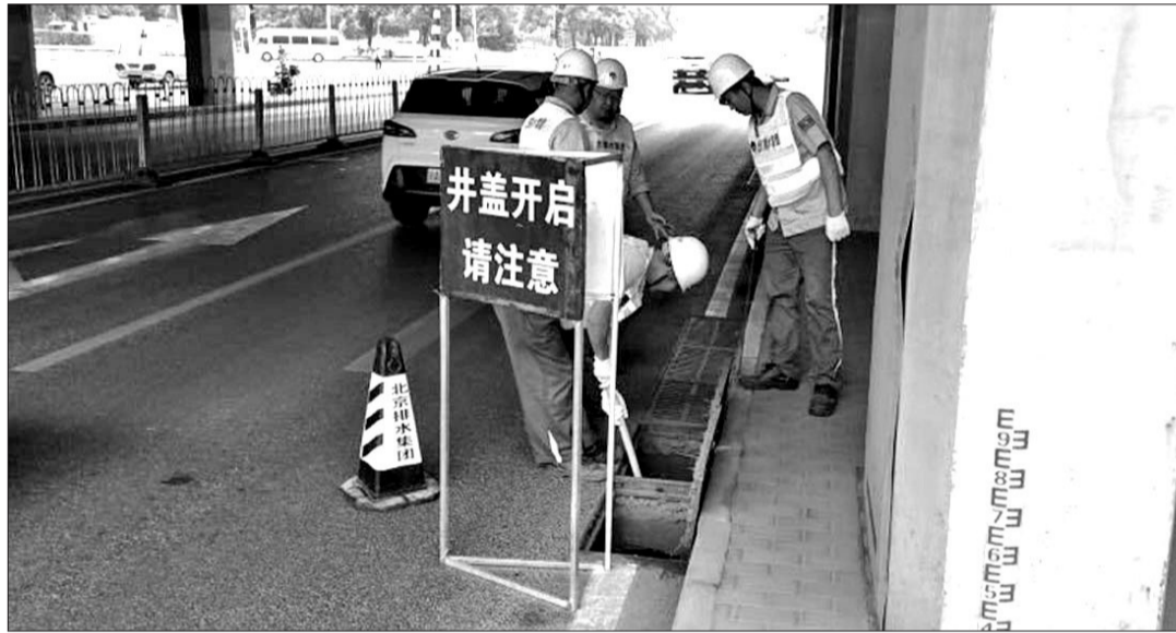
雨中,排水集团值守人员及时清理落叶,以免落叶堵塞排水口导致排水不畅
