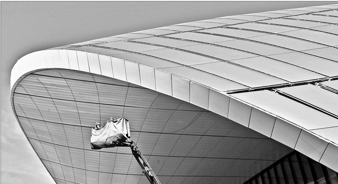
两名工人在吊车上作业
