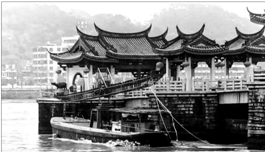
碰撞使西八桥墩栏杆和灯饰电线有一定程度损坏
