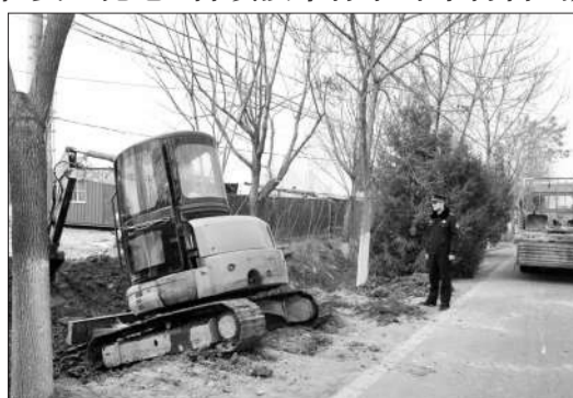
道路恢复施工现场
