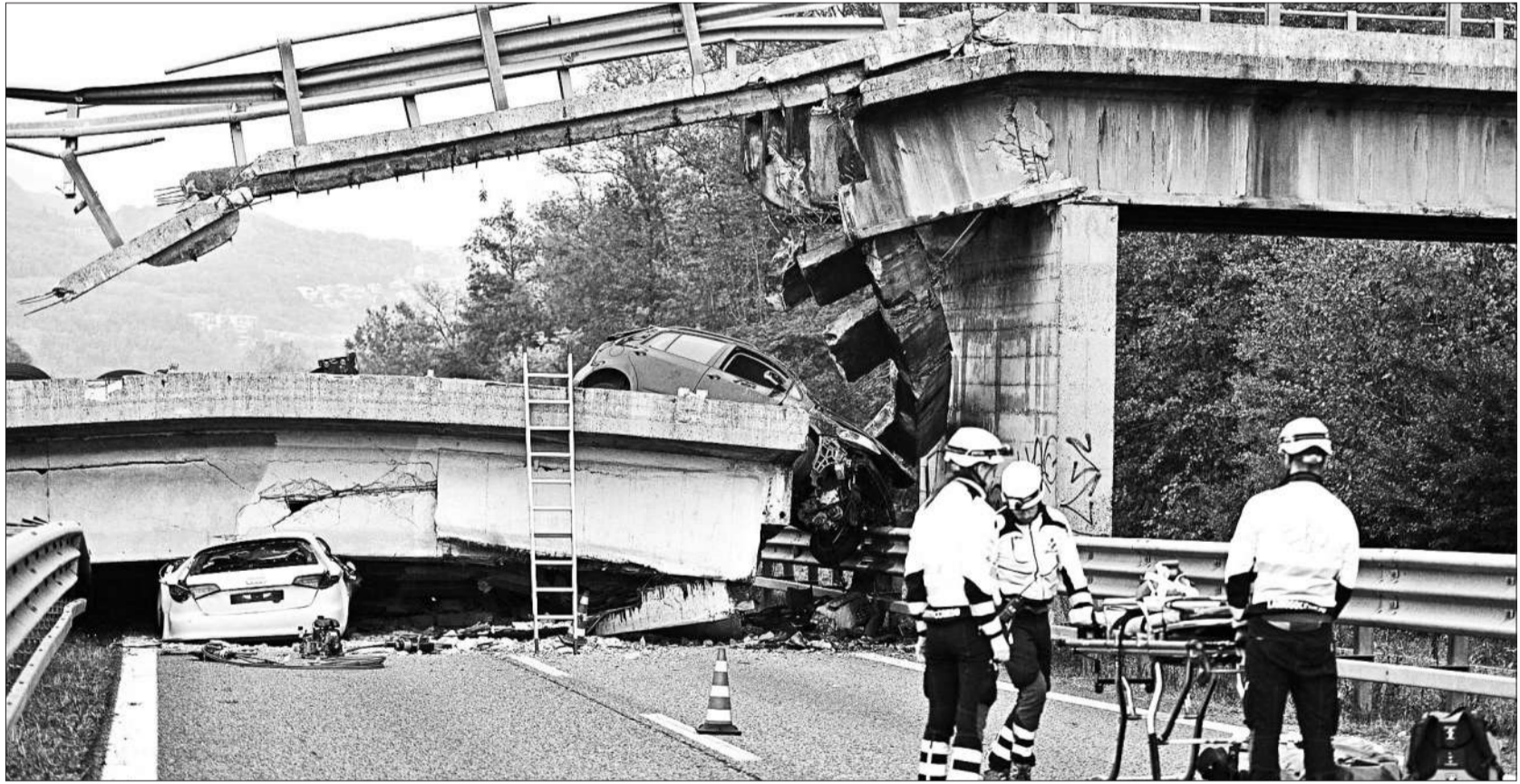
当地时间10月28日，意大利莱科至米兰一处公路桥在一辆大型拖车重压下垮塌，造成1人死亡，4人受伤，其中包括3名儿童。 供图/东方IC
