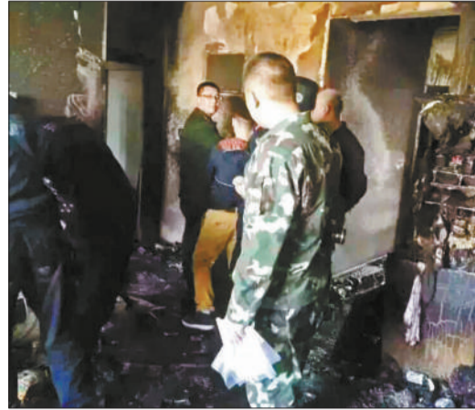
事发后,消防人员进入火灾现场查勘
